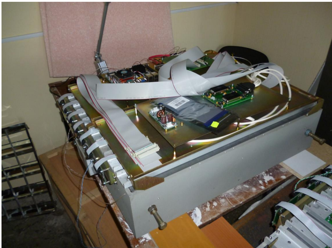
Рис. 3. Блок детектирования в процессе монтажа
