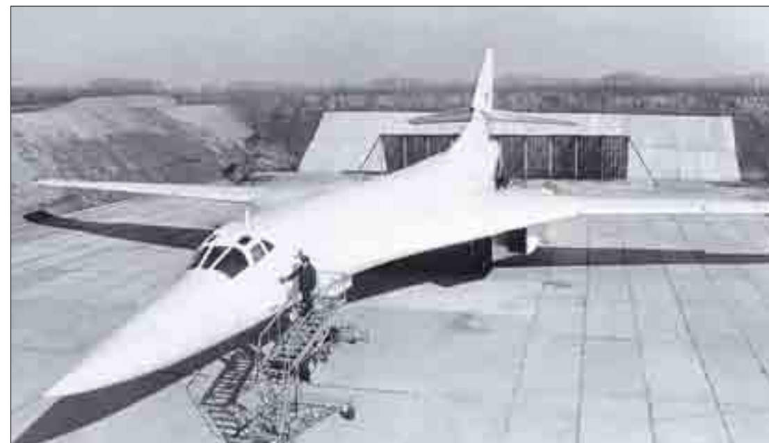
Один из первых серийных Ту-160 на аэродроме в Прилуках; обратите внимание: самолет на стоянке — с развернутым крылом; для технического обслуживания используется стремянка, предназначенная для бомбардировщиков типа Ту-22М
