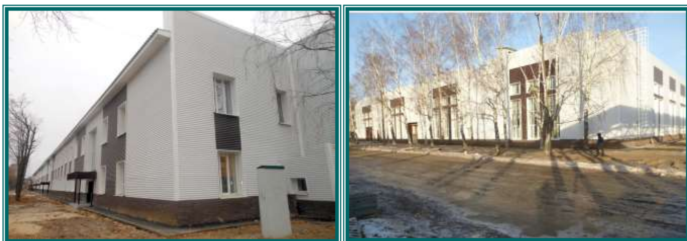
Фото 3 Корпус 73 после реконструкции
