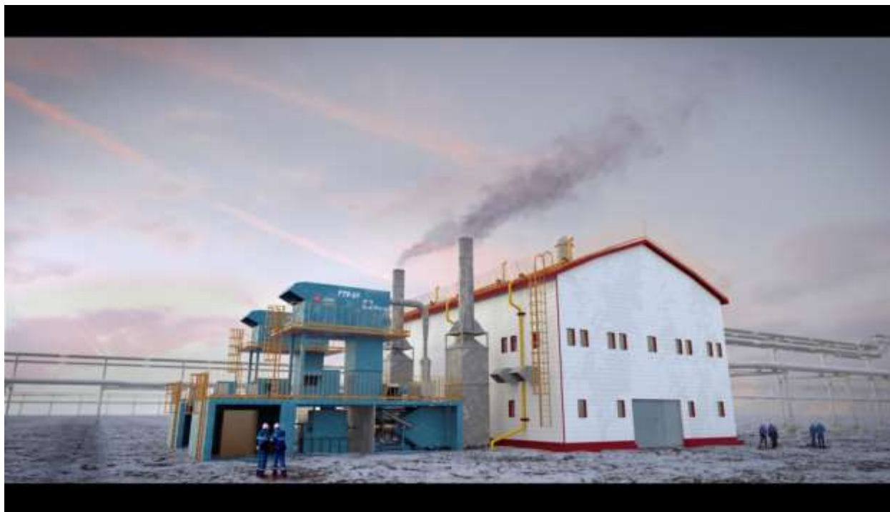
Рисунок 1 – Внешний вид ГТУ-2У в составе станции
